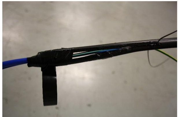
Kuva 20. Vaipan puoliskojen kiinnitys suojauputkiin teippaamalla.
