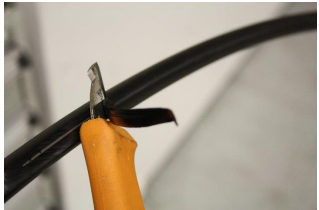
Kuva 2. Vaipan kuorinta vetolangan päältä.
