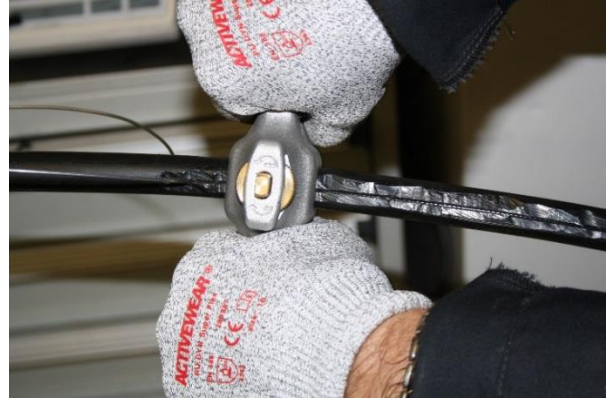
Kuva 7. Kaapelin vaipan halkaisu vetolankojen uria pitkin kaapelikuorijalla.
