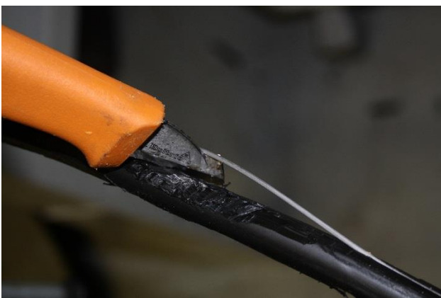
Kuva 3. Vetolangan kaivuu esille.
