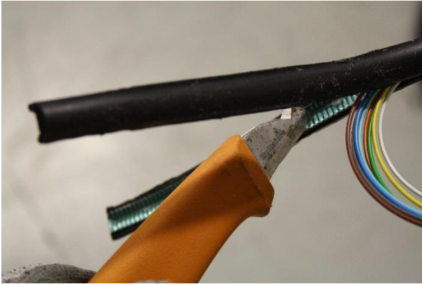
Kuva 11. Muovipinnoitteen poisto teräsnauhasta maadoitusliittimen kiinnityskohdasta.
