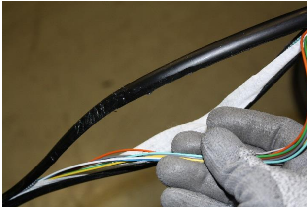
Kuva 9. Kuituputket vedetään nippuna ulos kaapelin ulkopäästä..
