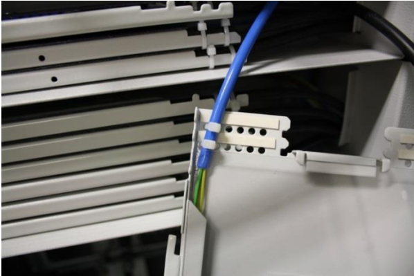
Kuva 14. Flex-kuituputket tuotu paineilmaputkessa jatkoslevylle.
