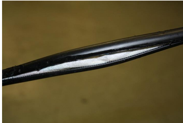
Kuva 8. Kaapeli on saatu halkaistua.
