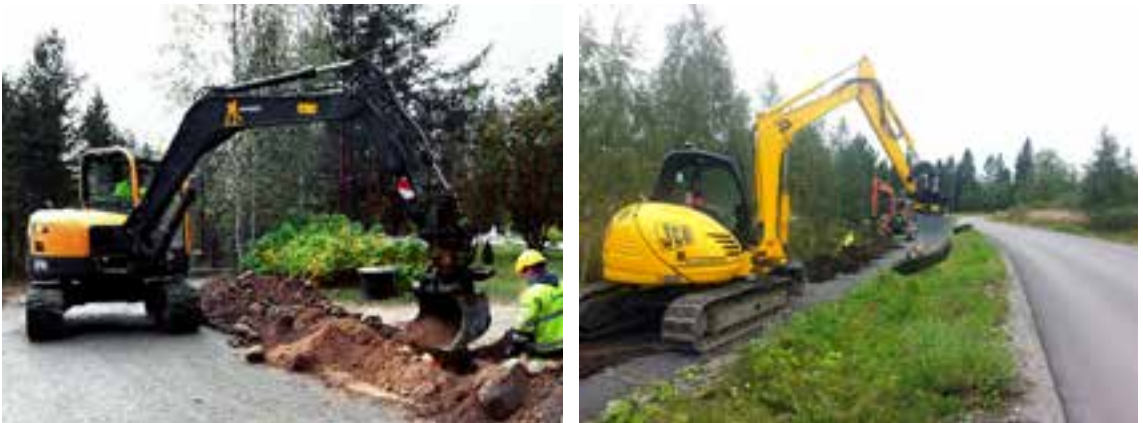
Kuva 7.13. Maakaapeleiden asennusta (Kuvat: Veljekset Toivanen Oy ja PyhäNet Oy).
