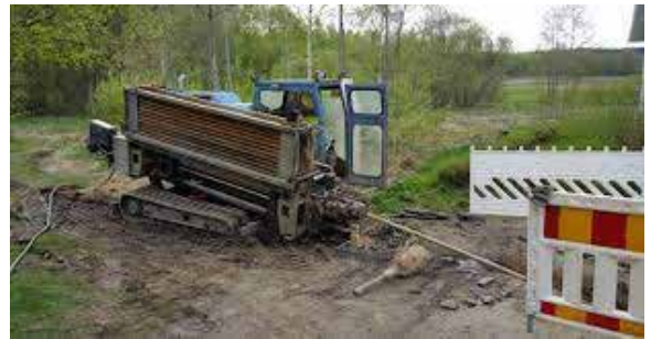
Kuva 7.24. Esimerkkejä tunkkauksesta ja suuntaporauksesta (Kuvat Suomen Alitustekniikka Oy)
