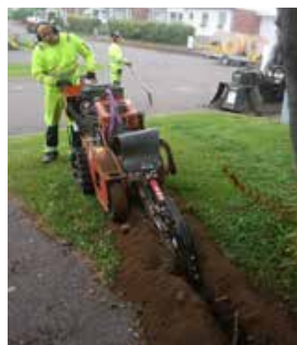
Kuva 7.22. Kaapeliuran jyrshintä taloliittymässä ketjukaivurilla (Kuvat: Nestor Cables Oy).
