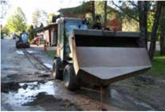
Kuva 7.20. Mikro-ojitusta pientaloalueella (Kuvat Nestor Cables)
