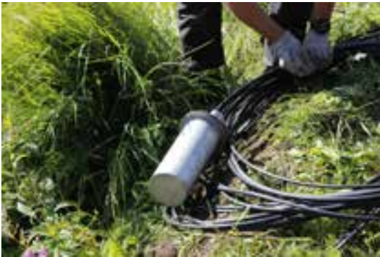
Kuva 4.28. Asennettuja ulkojatkoskoteloita (Kuvat Nestor Cables Oy).
