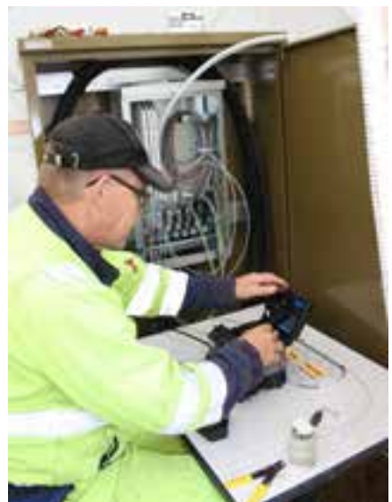
Kuva 8.4. Valokuidun jatkamista maastossa (Kuvat: Nestor Cables Oy).
