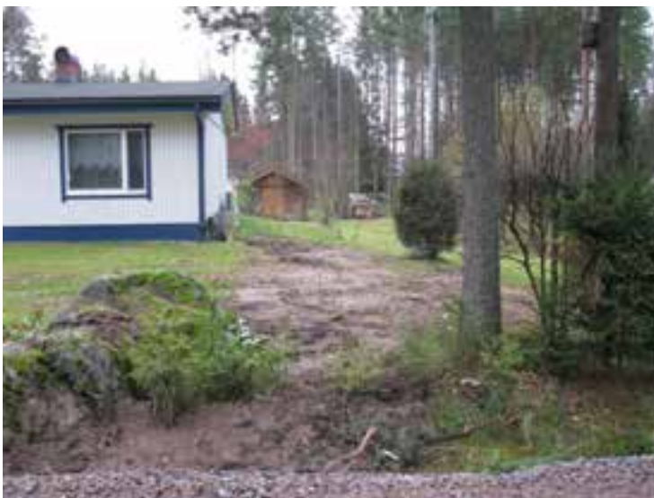
Kuva 7.35. Kaapelieppi vedetty talon nurkalle odottamaan päättämistyötä (Kuva: Nestor Cables Oy).
