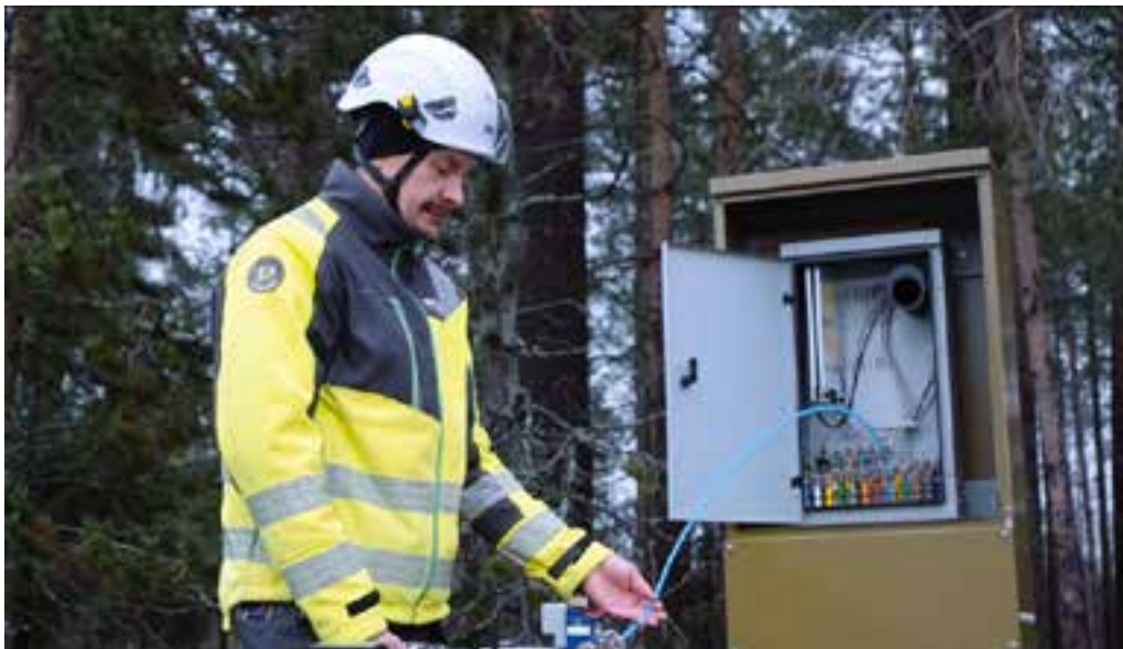
Kuva 7.12. Mikrokanavakaapelin puhallusta (Kuva: Nestor Cables Oy).
