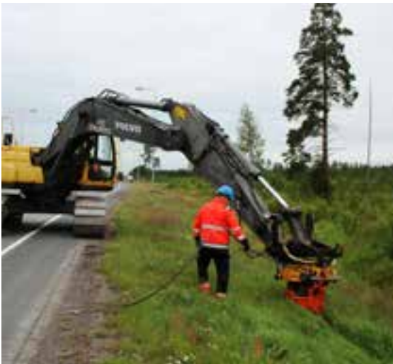
Kuva 7.17. Kaapeleiden aurausta (Kuvat: Nestor Cables Oy).
