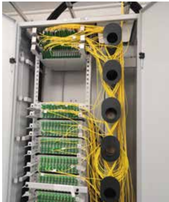
Kuva 6.7. Jaottimia sijoitettuna laitetilassa valokaapeleiden ristikytkentätelineeseen (Kuva: Televerkkopalvelut Seppo Marttila Oy).
