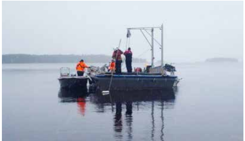
Kuva 7.29. Vesistökaapelin asennusta järveen (Kuvat Relacom Oy)
