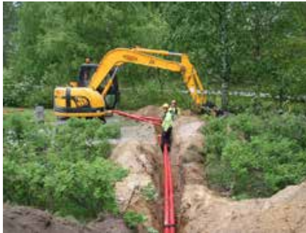
Kuva 7.5. Kanavaputkiston asennusta (Kuva: Veljekset Toivanen Oy).
