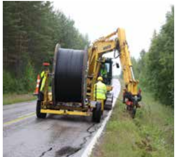
Kuva 7.17. Kaapeleiden aurausta (Kuvat: Nestor Cables Oy).
