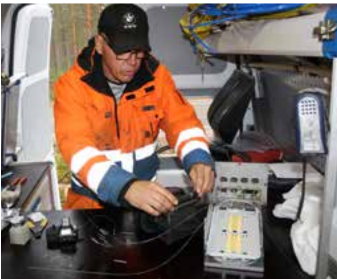
Kuva 8.4. Valokuidun jatkamista maastossa (Kuvat: Nestor Cables Oy).
