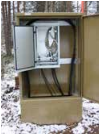
Kuva 8.10. Kylkioton periaate ja toteutus (Kuvat: Nestor Cables Oy)
