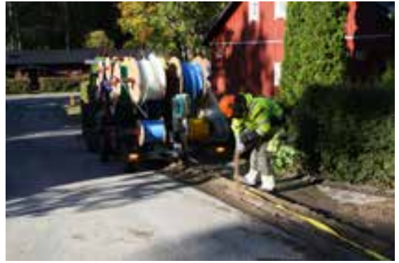
Kuva 7.20. Mikro-ojitusta pientaloalueella (Kuvat Nestor Cables)
