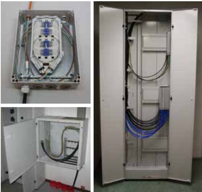
Kuva 4.30. Esimerkkejä asennetuista sisäjatkoskaapeista (Nestor Cables Oy).
