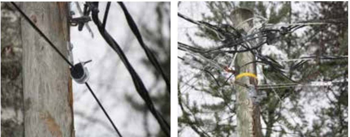
Kuva 7.26. Metalliton itsekantava (ADSS) ilmakaapeli asennettuna (Kuvat: Nestor Cables Oy).
