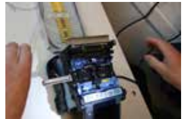
Jatkettu kuitu siirretään kuitujatkoskoneen uuniin.
