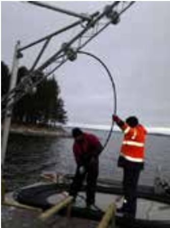
Kuva 7.29. Vesistökaapelin asennusta järveen (Kuvat Relacom Oy)
