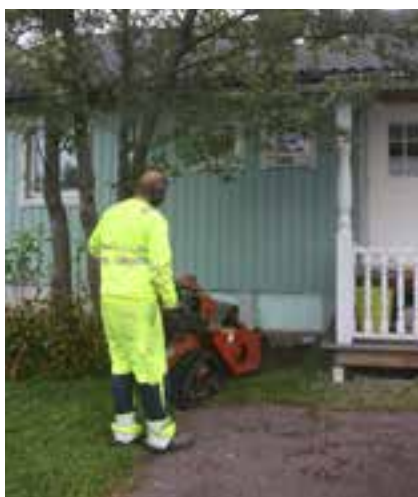
Kuva 7.22. Kaapeliuran jyrshintä taloliittymässä ketjukaivurilla (Kuvat: Nestor Cables Oy).
