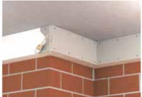
Palosuojakanava voidaan tasoittaa ja maalata, jolloin se on siisti ja huomaamaton.
