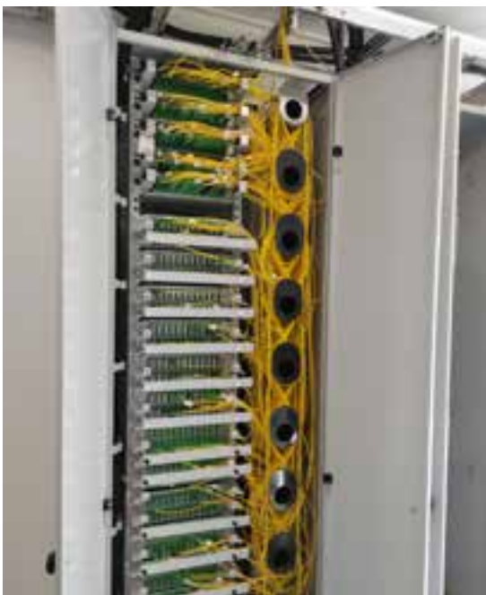
Kuva 6.7. Jaottimia sijoitettuna laitetilassa valokaapeleiden ristikytkentätelineeseen (Kuva: Televerkkopalvelut Seppo Marttila Oy).
